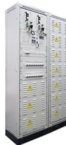
Шкафы управления оперативным током серии (ШУОТ)
