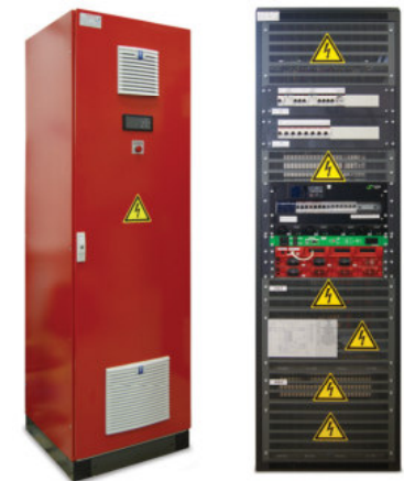
Электропитающие установки (ЭПУ)
