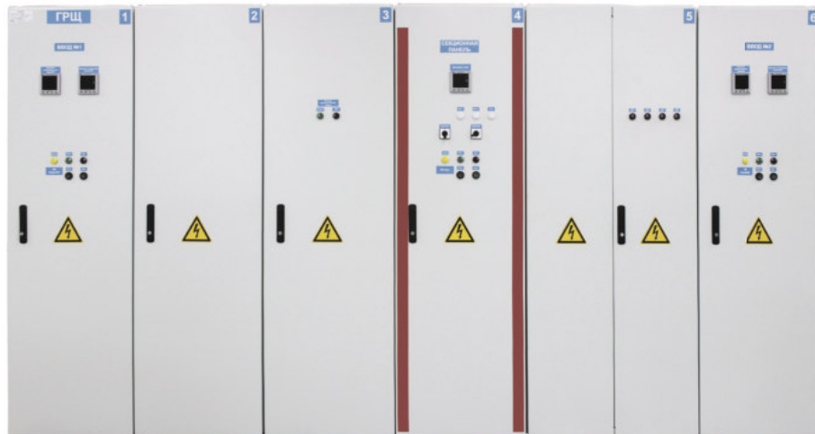
Главные распределительные щиты (ГРЩ)
