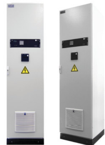
Шкафы оперативного тока (ШОТ)
