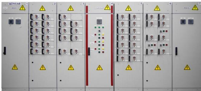
НКУ в составе ЩСУ предназначены для ввода и распределения электроэнергии, автоматического ввода резерва электропитания, управления и защиты различных электротехнических устройств, электроприводов (в том числе плавного пуска электродвигателей), нагревательного и осветительного оборудования в сетях трехфазного переменного тока напряжением 380/220 В частотой 50 Гц.
