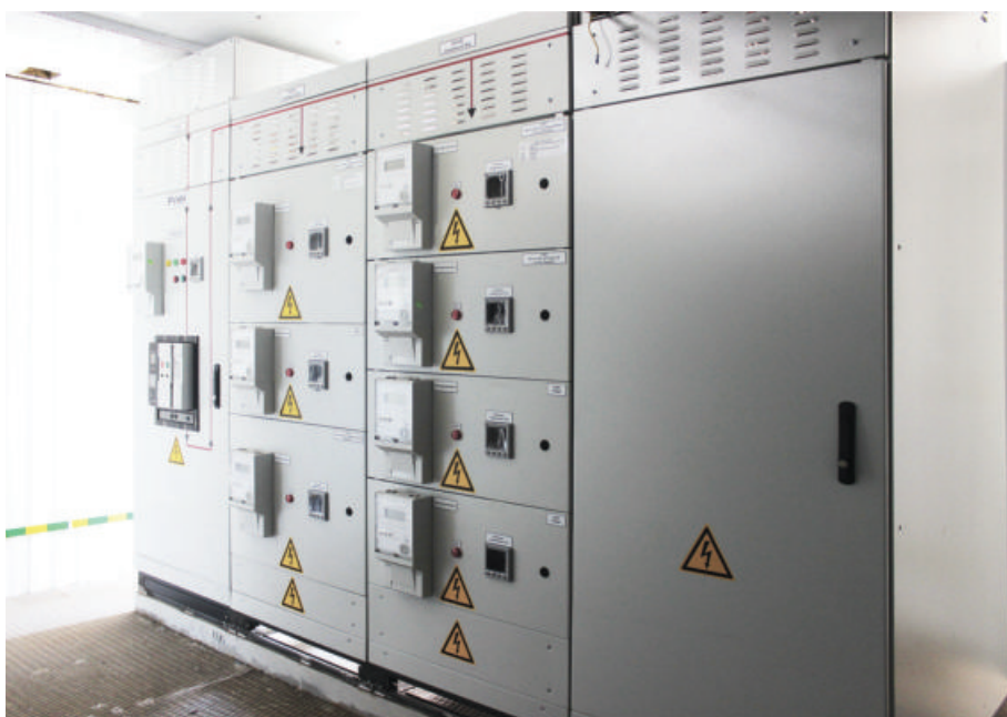
КТП – комплектная трансформаторная подстанция
